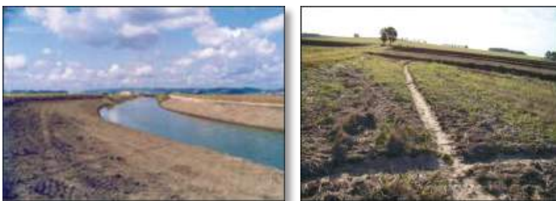
Figura 28 - Valas de drenagem superficial
