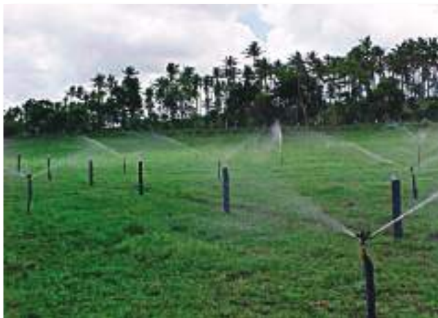
Figura 22 - Sistema de Aspersão fixa
