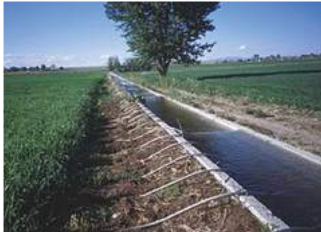
Figura 4 - Canal de irrigação com sistema de sifão
