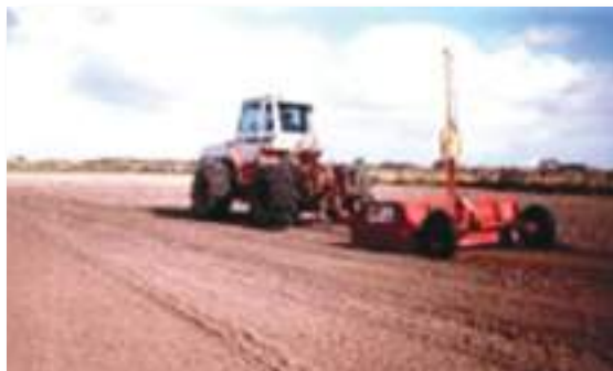
Figura 7 - Recetor de raios laser montado numa niveladora na execução da sistematização em solo seco.
